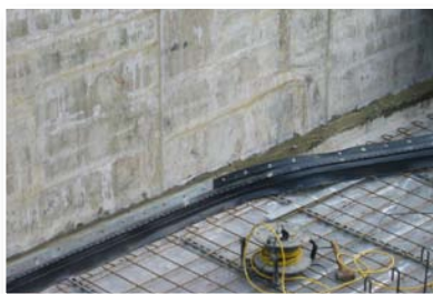
Alt-Neubauanschluss/ Anflansungen
